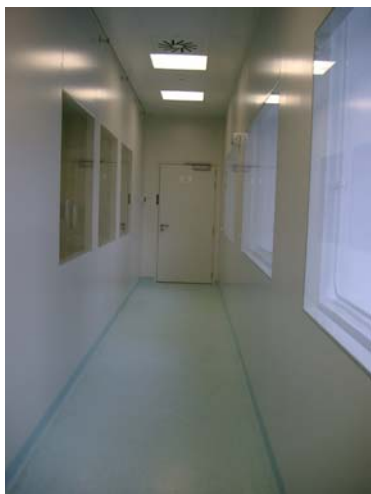
Przykłady zabudowy pomieszczeń czystych panelami systemu GMPs.
