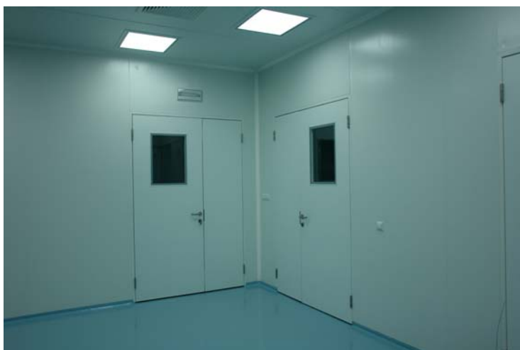
Przykłady zabudowy pomieszczeń czystych panelami systemu GMPs.
