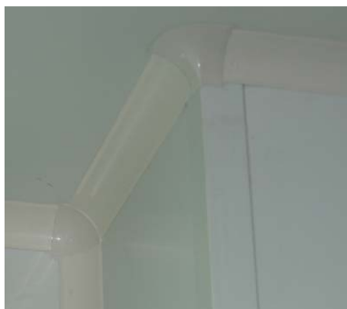
Przykładowe zastosowania wyoblających połączeń między płytami i sufitem
