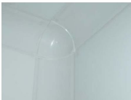
Przykładowe zastosowania wyoblających połączeń między płytami i sufitem
